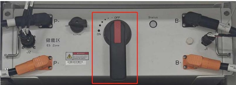
Abbildung 62: Anschlusskasten für hohe Spannung Batterietrennschalter QB
