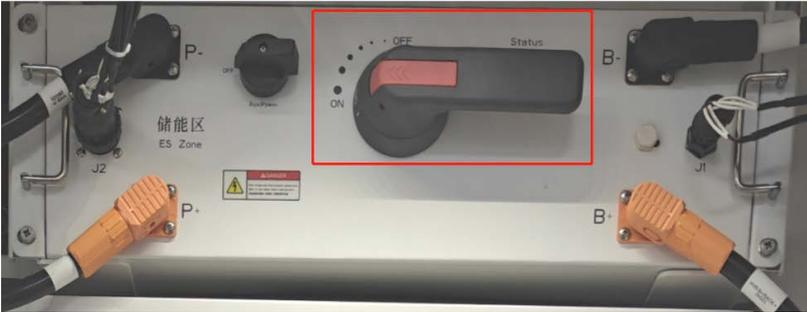
Abbildung 60: Batterietrennschalter QB im Anschlusskasten für hohe Spannungen
