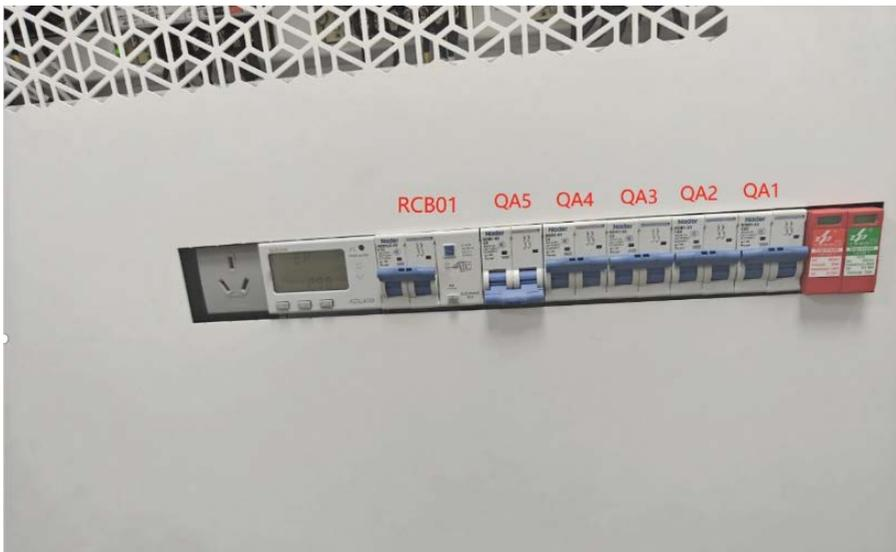
Abbildung 59: Schalter im Hilfsstrommodul
