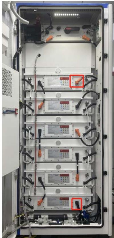
Abbildung 58: Lage der positiven und negativen Stecker des Batterieclusters
