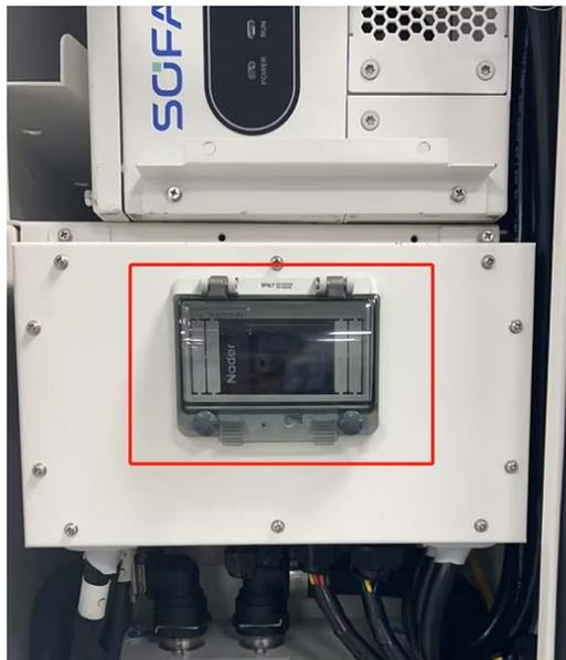
Abbildung 61: PCS AC-seitiger Schalter QA0 des Energiespeicherschranks
